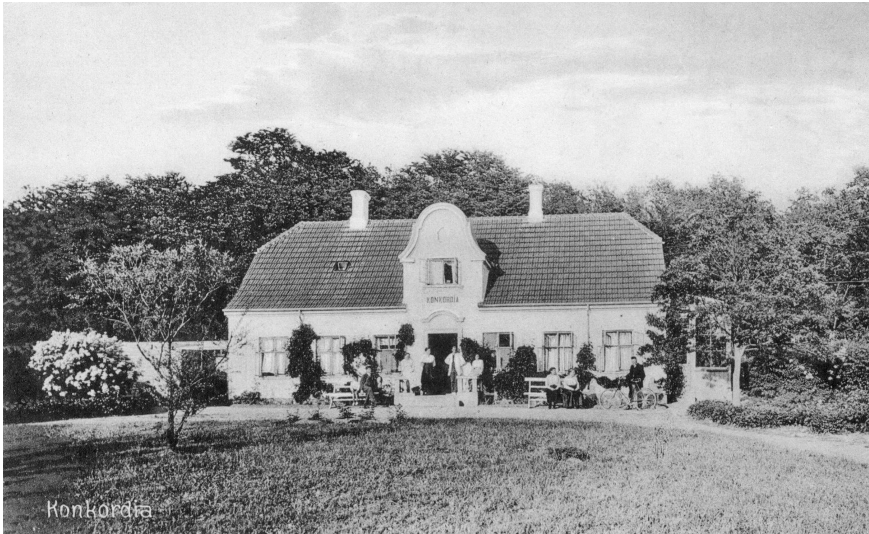
"Skovhuset" og tilstødende jorde som Alfred Christensen solgte til "Danske Afholdsvenners Redningsarbejde for Alkoholister" ved overlæge Carl Ottosen i 1906. Huset blev i den forbindelse omdøbt til "Konkordia", idet behandlingshjemmet for kvinder med et alkoholmisbrug på Faxe Ladeplads netop blev flyttet til Nærum, og det hed "Konkordiahuset".
