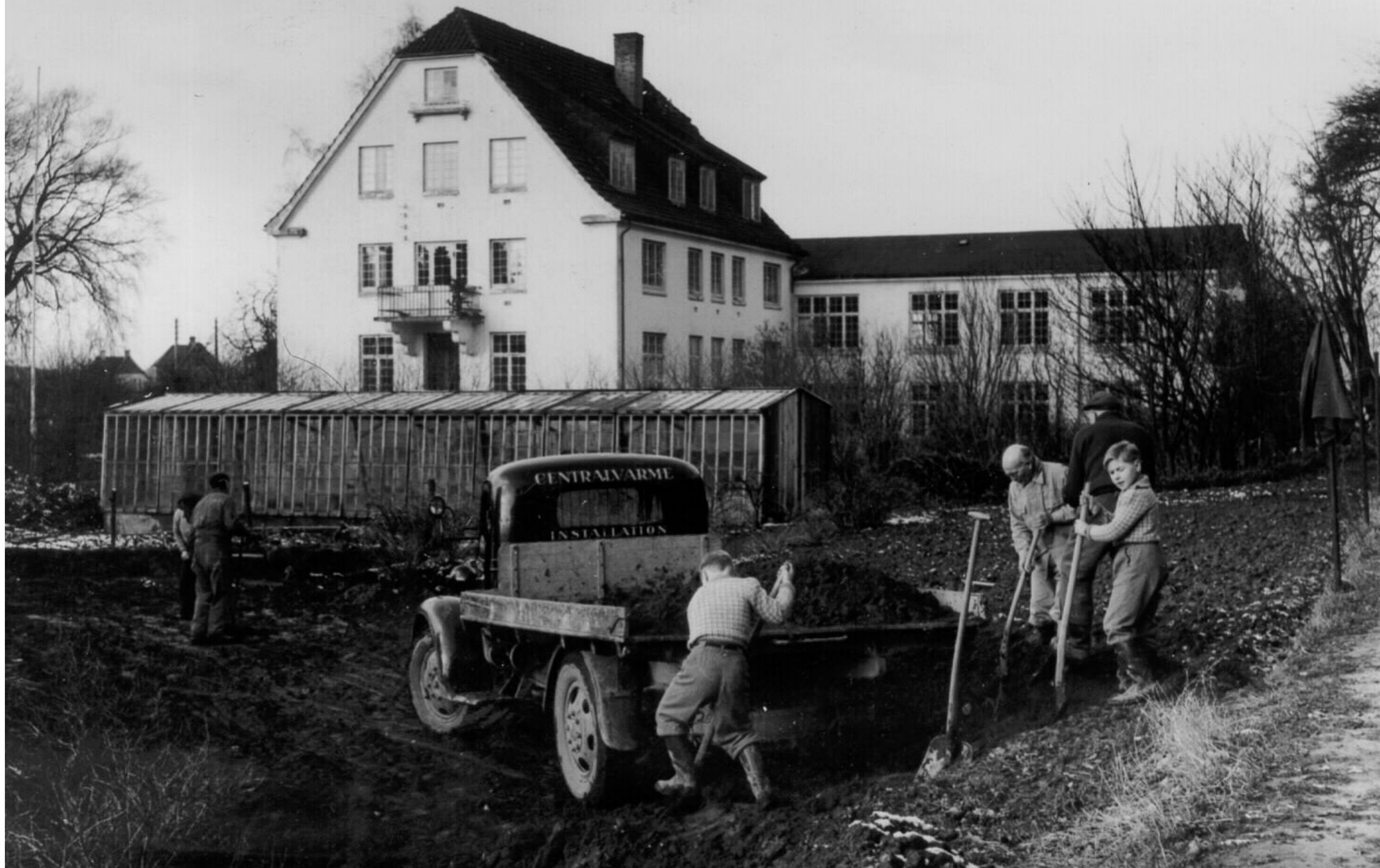
Kirkebyggeriet er gået i gang 1957
